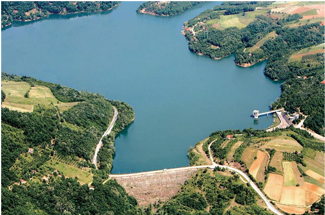
Слика 2. Насута брана (средина) и евакуациони прелив (десно) акумулације Ћелије
